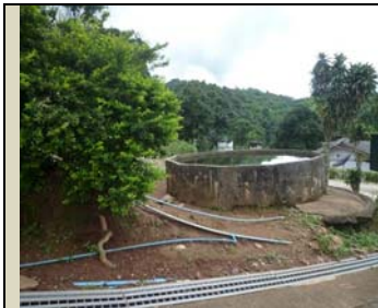
共築的接水池，洗澡、洗衣用
